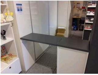
Bild von erniedrigtem Counterbereich für Kommunikation mit Rollstuhlfahrern
