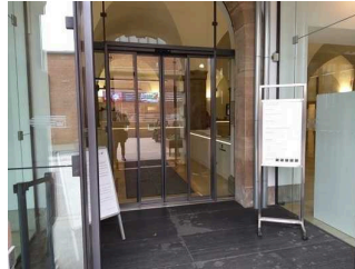
2. Eingangstür am Haupteingang (Windfang)
