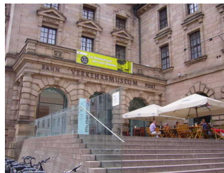
Treppen am Eingang
