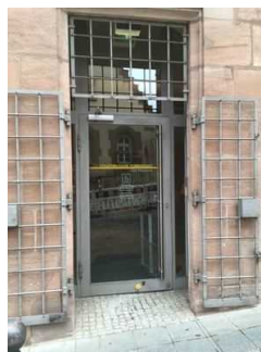
Nebeneingang von innen
