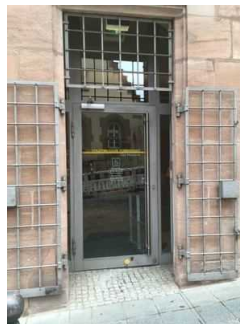
Nebeneingang von innen
