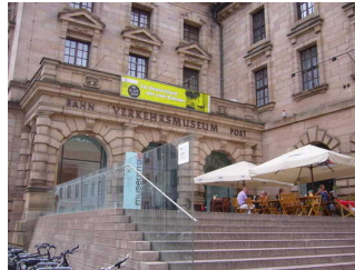
Treppen am Eingang
