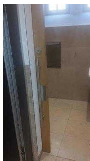
Eingangstür in den Sanitärraum
