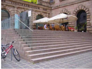
Treppe am Haupteingang
